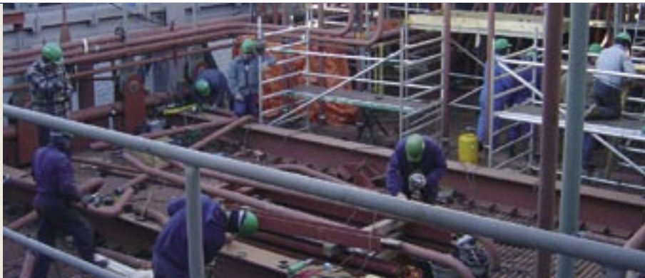
Sikkerhed har stået højt på dagsordenen under opførelsen af Europas største affaldsovn.
